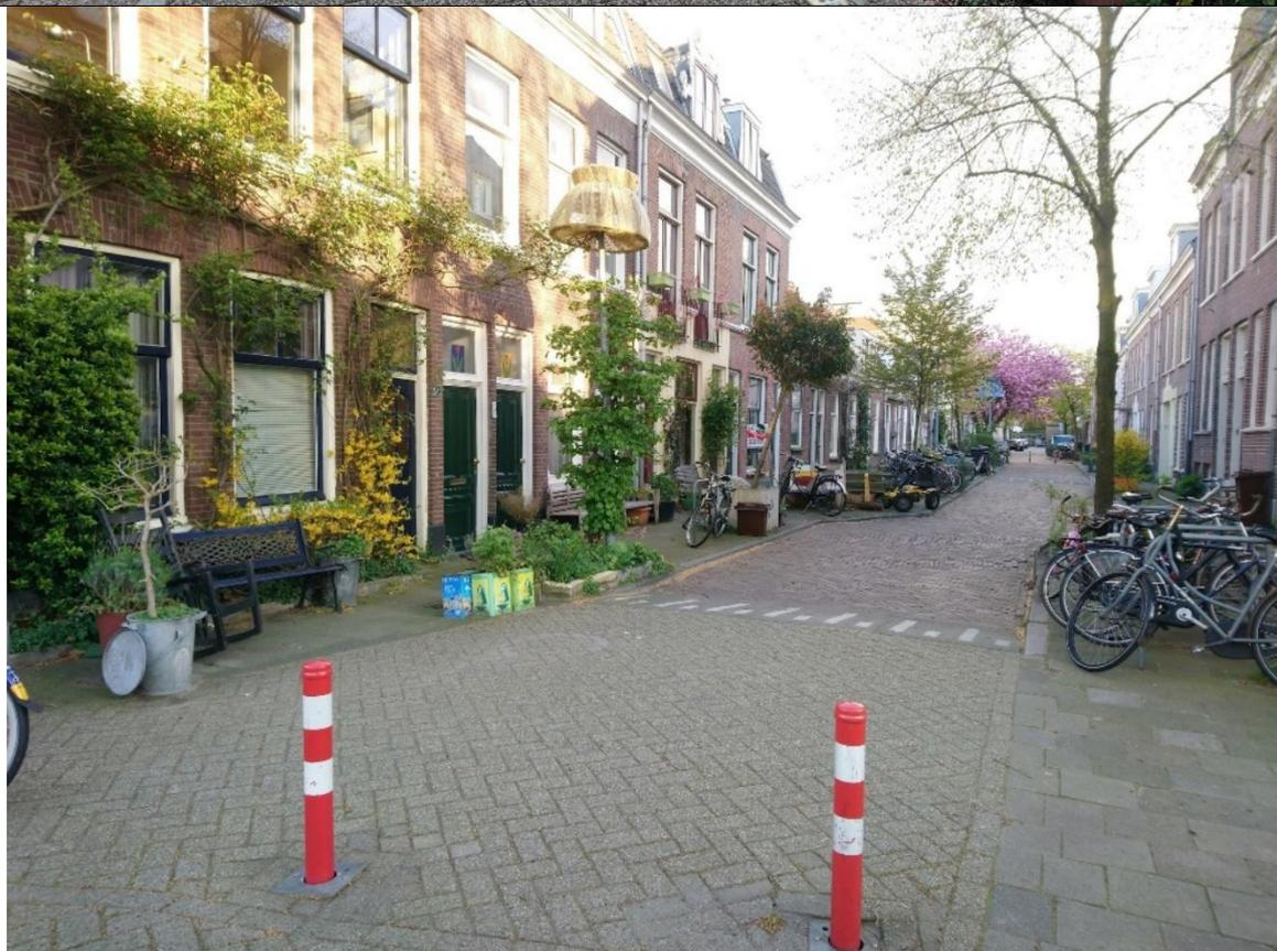
**Esempio di moderazione del traffico su strada 30 Km/h tramite rialzamento dell'intersezione stradale e creazione di disassamento (chicane).**
