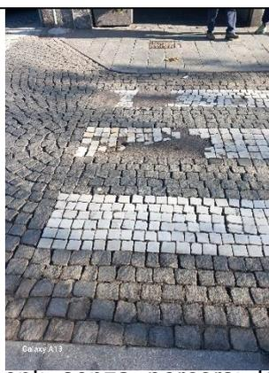
Attraversamenti senza percorsi tattili, talvolta non illuminati e, soprattutto in area centrale e lungo C.so indipendenza, con pavimentazione in porfido non mantenuta e inadattata alla percorribilità in carrozzina.
