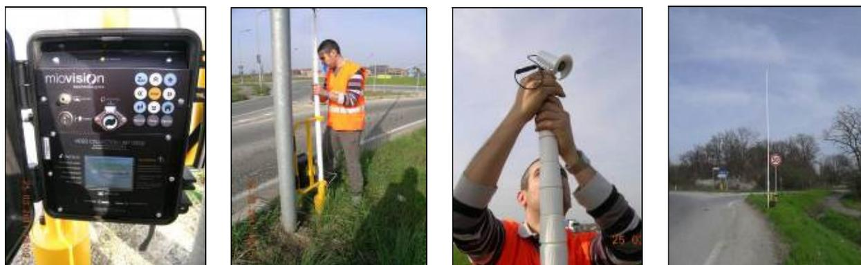
*Figura 92 – Esempi di posizionamento delle telecamere ad infrarossi*
