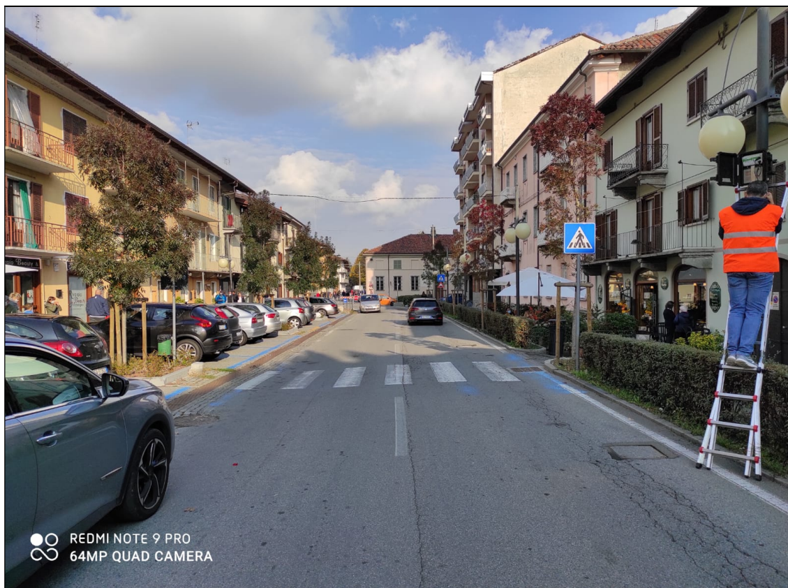
Figura 19 – Posizionamento del radar SDR presso la sezione 11
