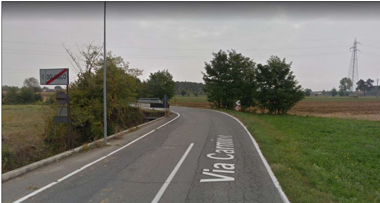
Figura 48 – Limite di velocità in corrispondenza della sezione 2 – dir. IN
