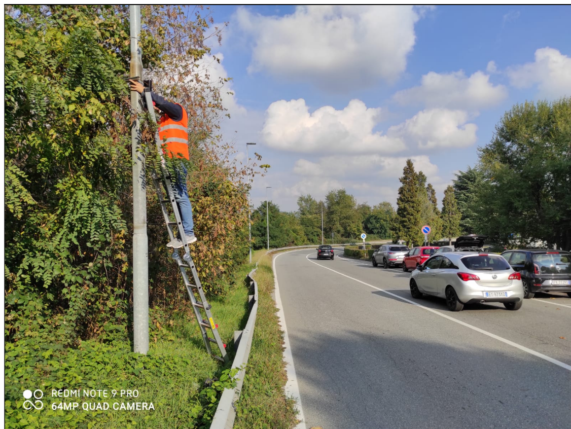
Figura 18 – Posizionamento del radar SDR presso la sezione 10
