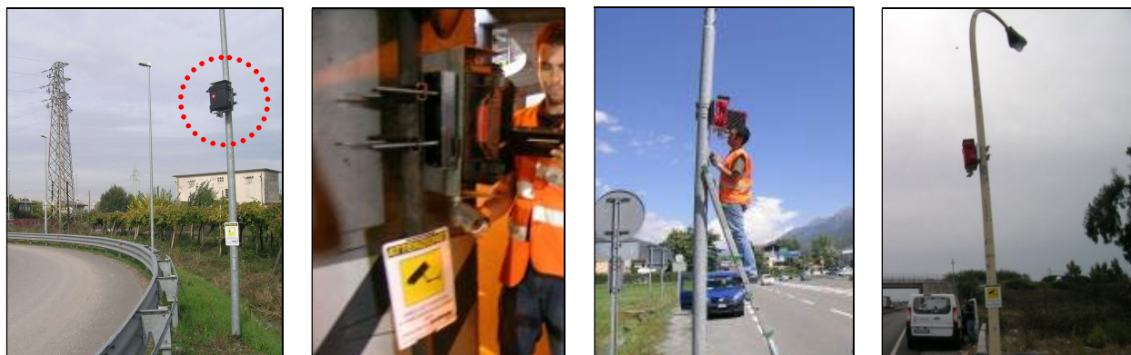
Figura 4 – Esempi di posizionamento delle telecamere ad infrarossi
