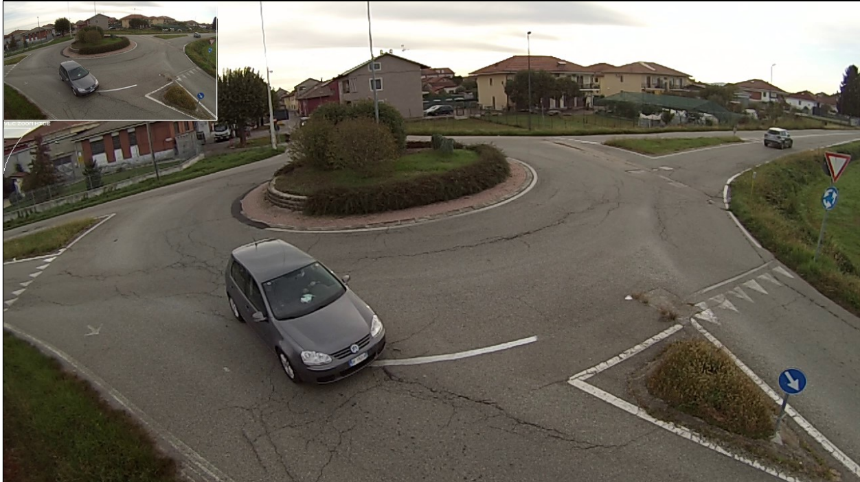
Figura 22 – Posizionamento delle telecamere in corrispondenza del nodo 20
