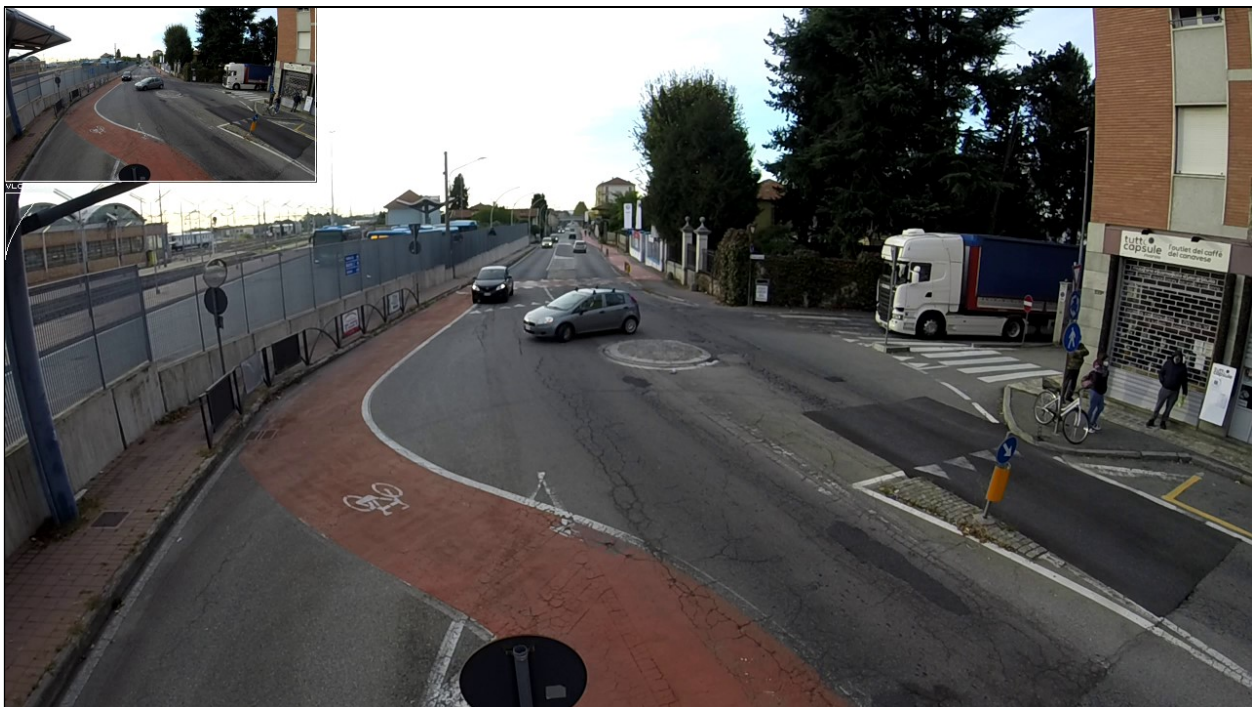
Figura 19 – Posizionamento delle telecamere in corrispondenza del nodo 17
