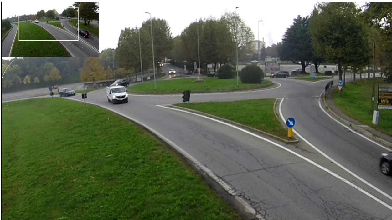
Figura 13 – Posizionamento delle telecamere in corrispondenza del nodo 7 (tlc 02)
