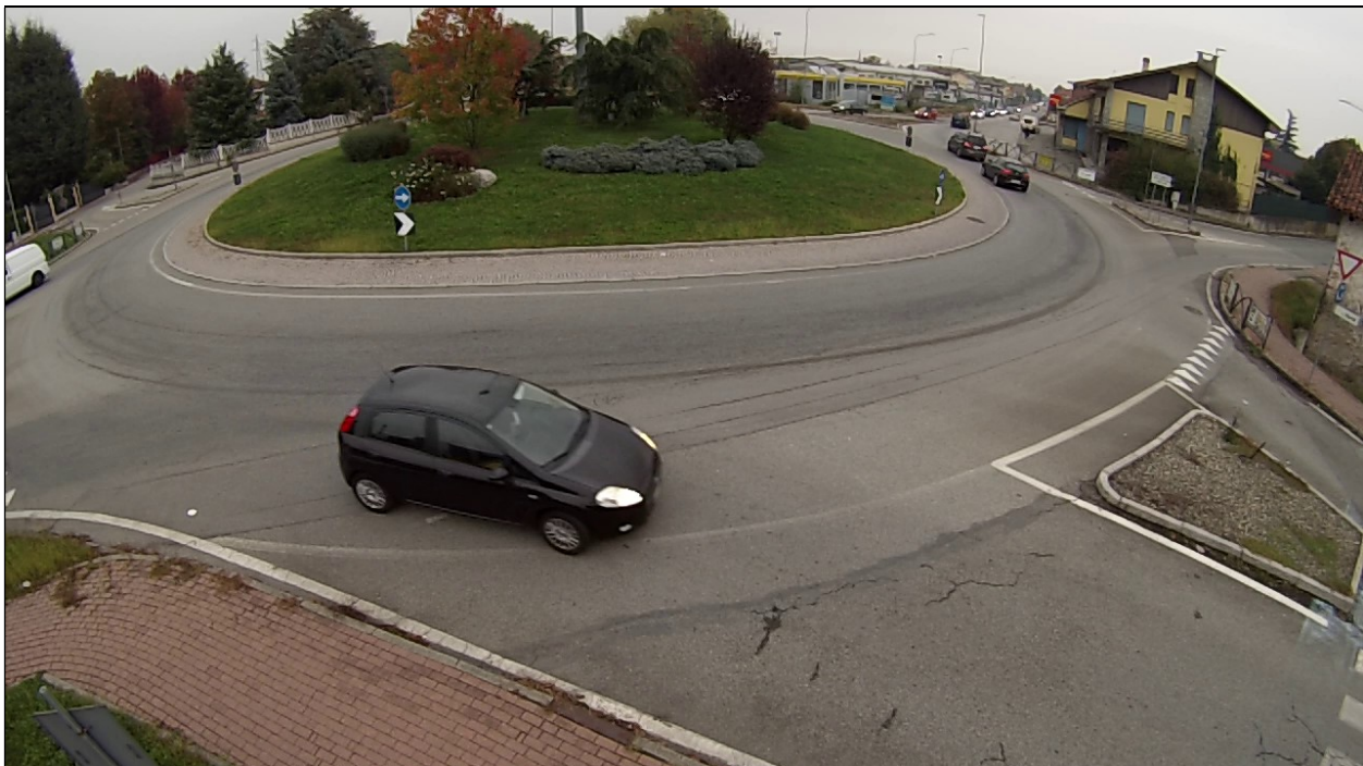
Figura 25 – Posizionamento delle telecamere in corrispondenza del nodo 21 (tlc 3)
