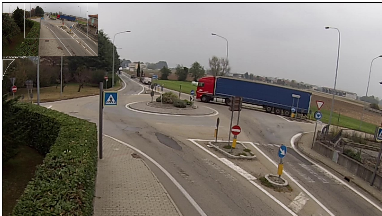
Figura 30 – Posizionamento delle telecamere in corrispondenza del nodo 25
