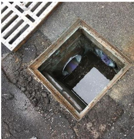
Pozzetto di ispezione
