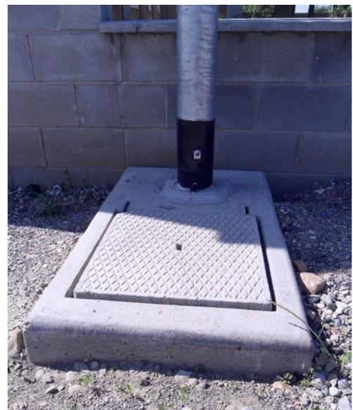
Figura 09– Plinto prefabbricato per palo IP con pozzetto integrato
