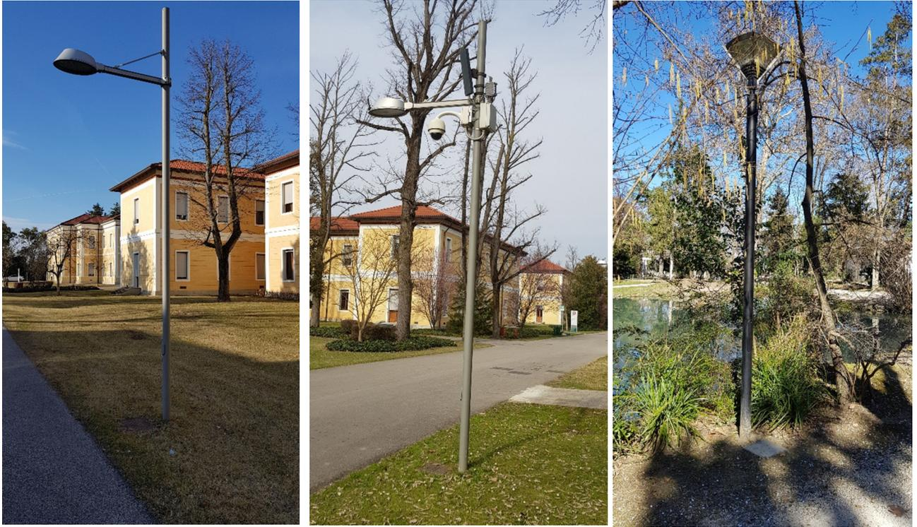
Figura 07 – Pali per IP ideati per la posa di telecamere. A destra una soluzione idonea a siti di rilievo naturalistico.
