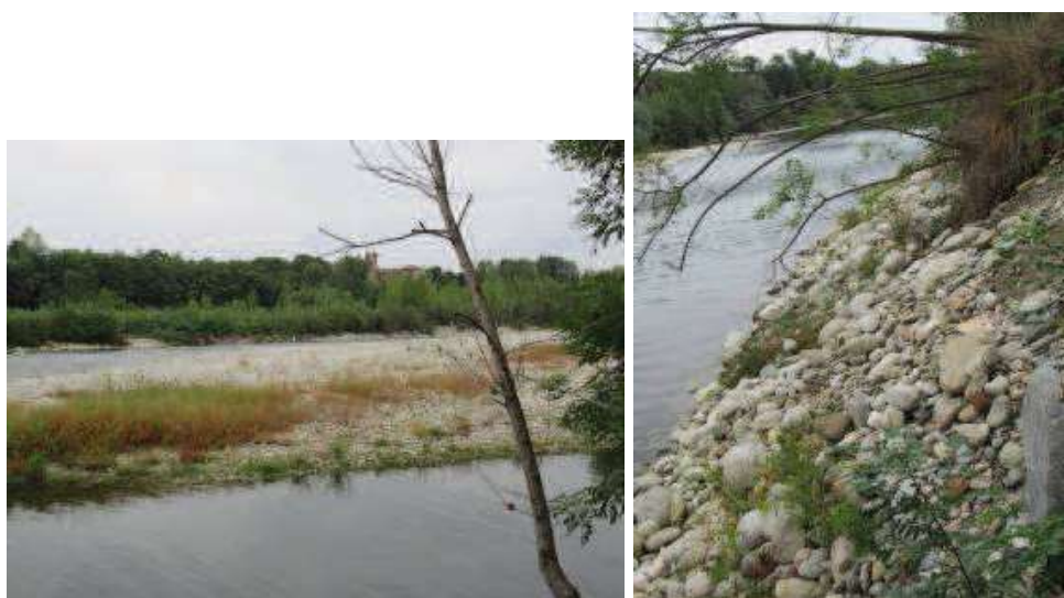
Foto 54-55. Particolare della difesa spondale costituita da ciottoli di medie e grandi dimensioni costantemente soggetta a fenomeni erosivi.
